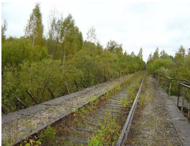
Рис. 1. Железнодорожный мост через р. Б. Кокшага в ГПЗ «Большая Кокшага» (2004 г.).
