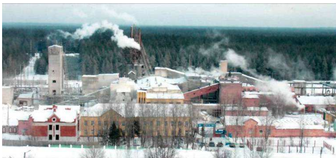
Рис. 4.2. Марийский завод силикатного кирпича (объекты исследования – на заднем плане).
